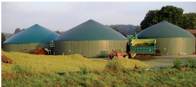
Abb. 1: Landwirtschaftliche Biogasanlage in der Nähe der Stadt Bielefeld (NRW). Die 500 kW Anlage besteht aus zwei Fermentern und einem weiteren Fermenter, in dem Gärreste gelagert werden. Die Anlage wird kontinuierlich mit Mais-Silage, Grünroggen und Gülle beschickt.
