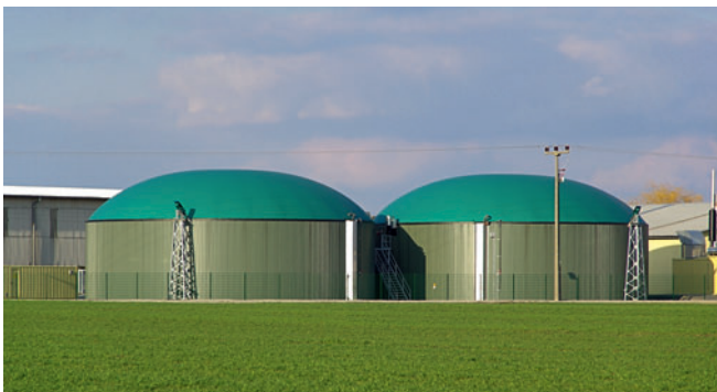
Bioenergie, wie hier aus einer Biogasanlage, hat eine besondere Bedeutung für die regenerative Energieproduktion, da sie zu allen Zeiten verfügbar ist (Foto: Lianem – Fotolia.com).
