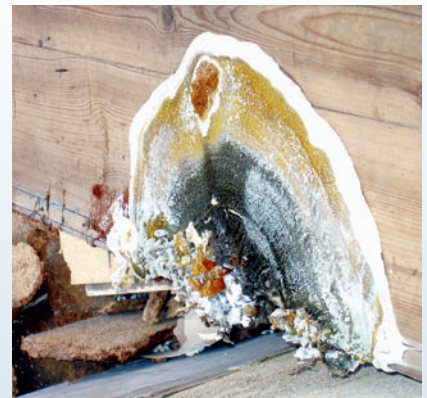
Bevor der echte Hausschwamm einen solchen Fruchtkörper ausbildet, wächst er oft jahrelang unbemerkt im Holz (Foto: HKI/FSU).
